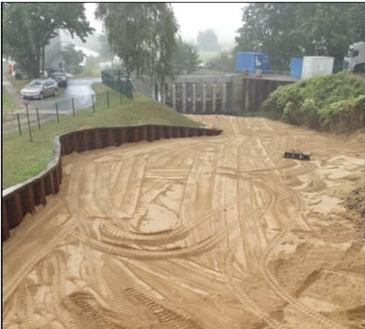
Bild: Verfüllung Fischpass Geesthacht / 20.09.2019
