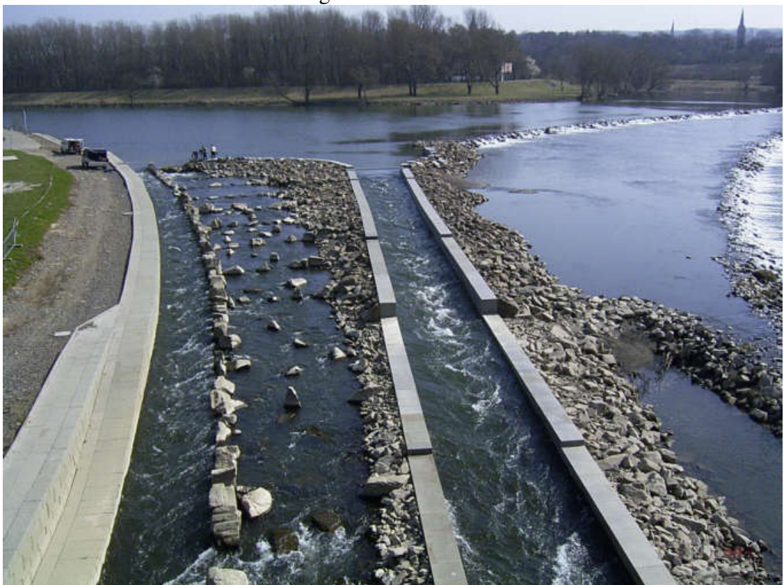
Nr.8: Kombinationsbauwerk Hattingen
